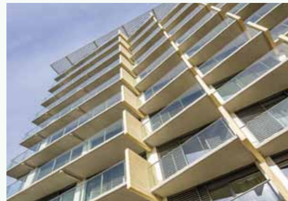
Kostverlorenhof Amstelveen, renovatie exterieur
